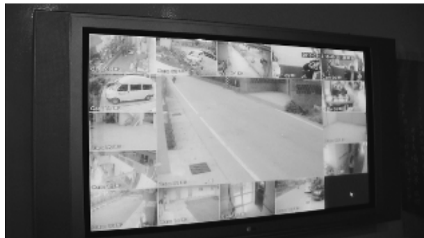
図 31. 屋内外に設置された 防犯カメラ映像をチェックできる監視システムパネル
